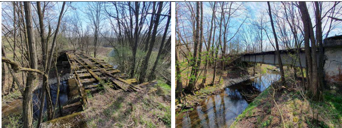
Szentjakabi-patak egykori vasúti hídja - új szerkezet készül helyette
